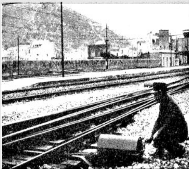
FIG. 31 — MANOVRA A MANO DELLA CASSA TIPO A. E. G. posizione voluta gli aghi del deviatoio. (Fig. 31).
